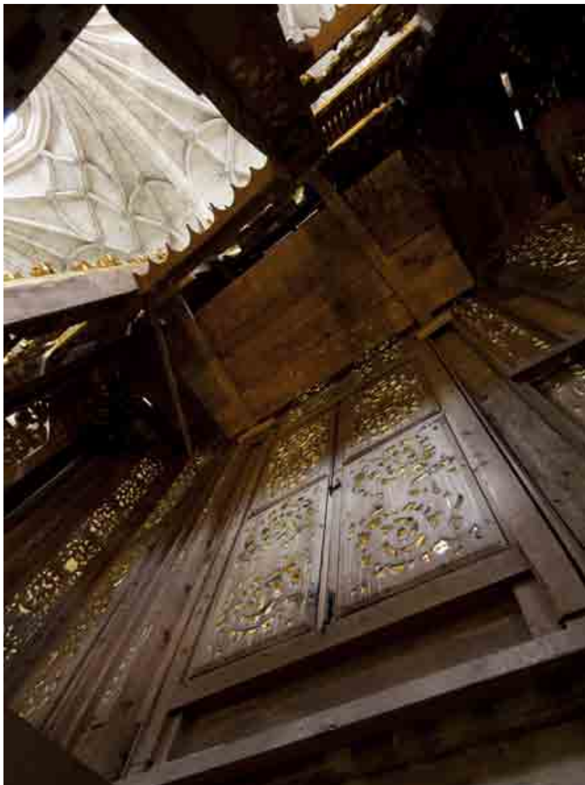
Interior de la caja sin los tubos, durante los procesos de restauración.
