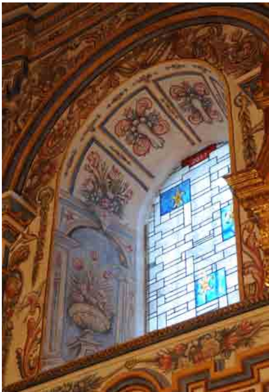
Detalle de uno de los dos huecos con la vidriera colocada en la intervención en el inmueble.
