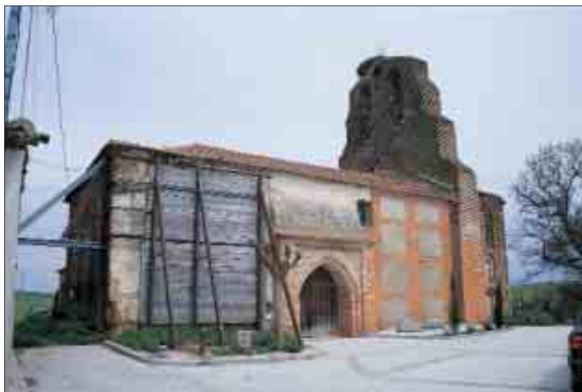
La Iglesia de Turra de Alba (Salamanca) pertenece a la fase clásica de la arquitectura mudéjar
