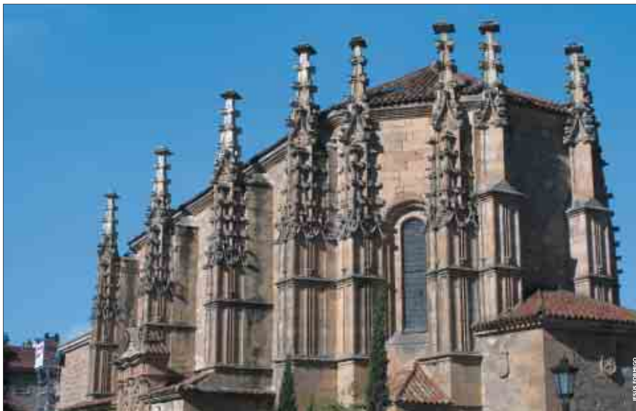
Los pináculos que coronan los contrafuertes dotan al templo de un aspecto claramente gótico
