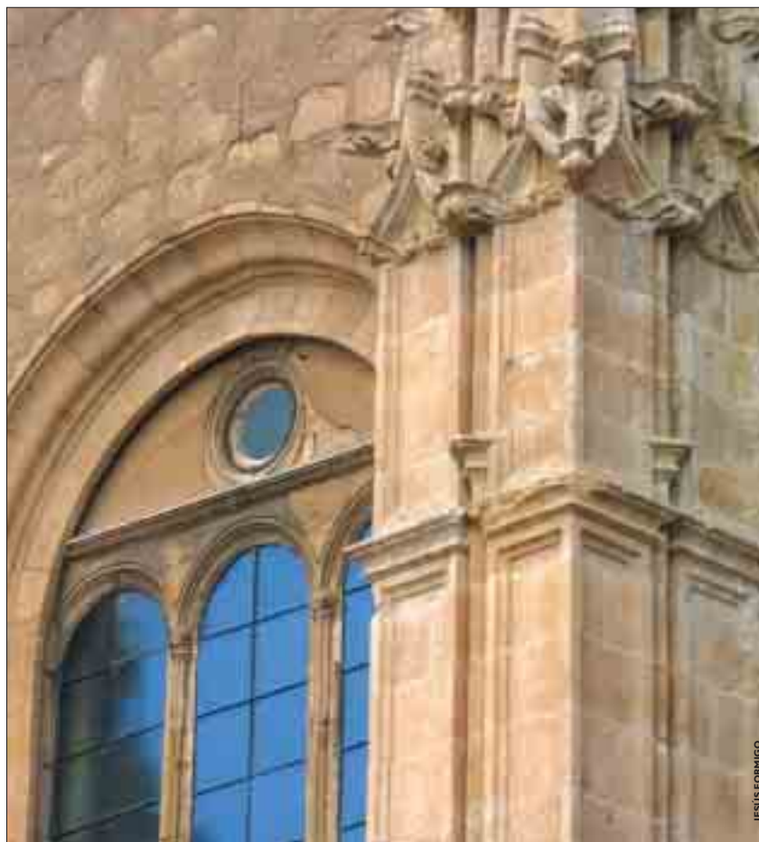
Los ventanales tienen tracería renacentista, con doble mainel y óculo
