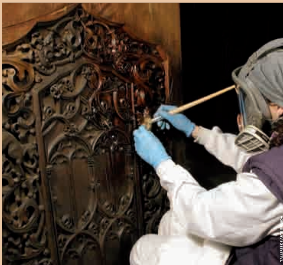
Labores de limpieza de detalles ornamentales.
