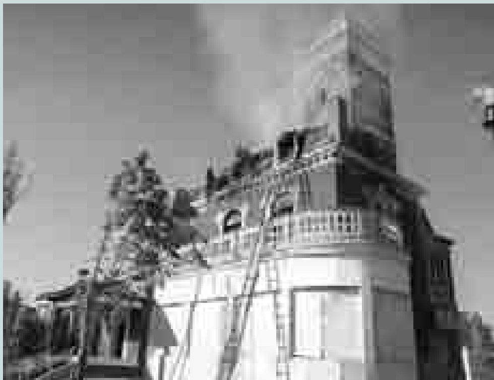
La Casa Luelmo vista desde el paseo de Zorrilla después del incendio que produjo el derrumbe de la cubierta y alfarjía de su zona meridional.
