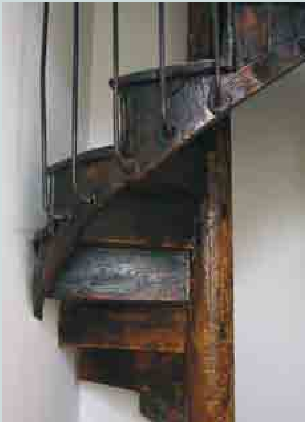
En la restauración se ha conservado la escalera de caracol original por la que se accede a lo alto de la torre.
